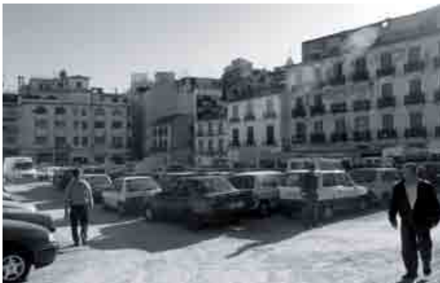
Degradado entorno de calle Camas en 1996 y el estado actual.
