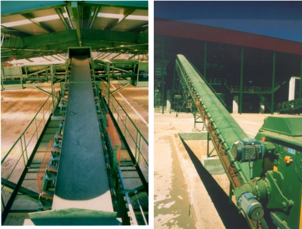
Planta de Reciclaje de Residuos Sólidos
