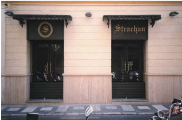
Comercio con la fachada rehabilitada en calle Strachan
